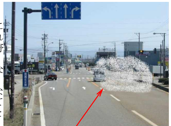
視野欠損箇所の映像（例）
